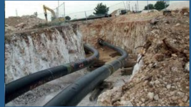
Exemples de canalisations NaTran, avant enfouissement
