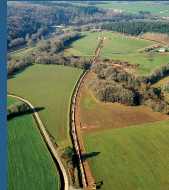
Exemples de canalisations NaTran, après enfouissement
