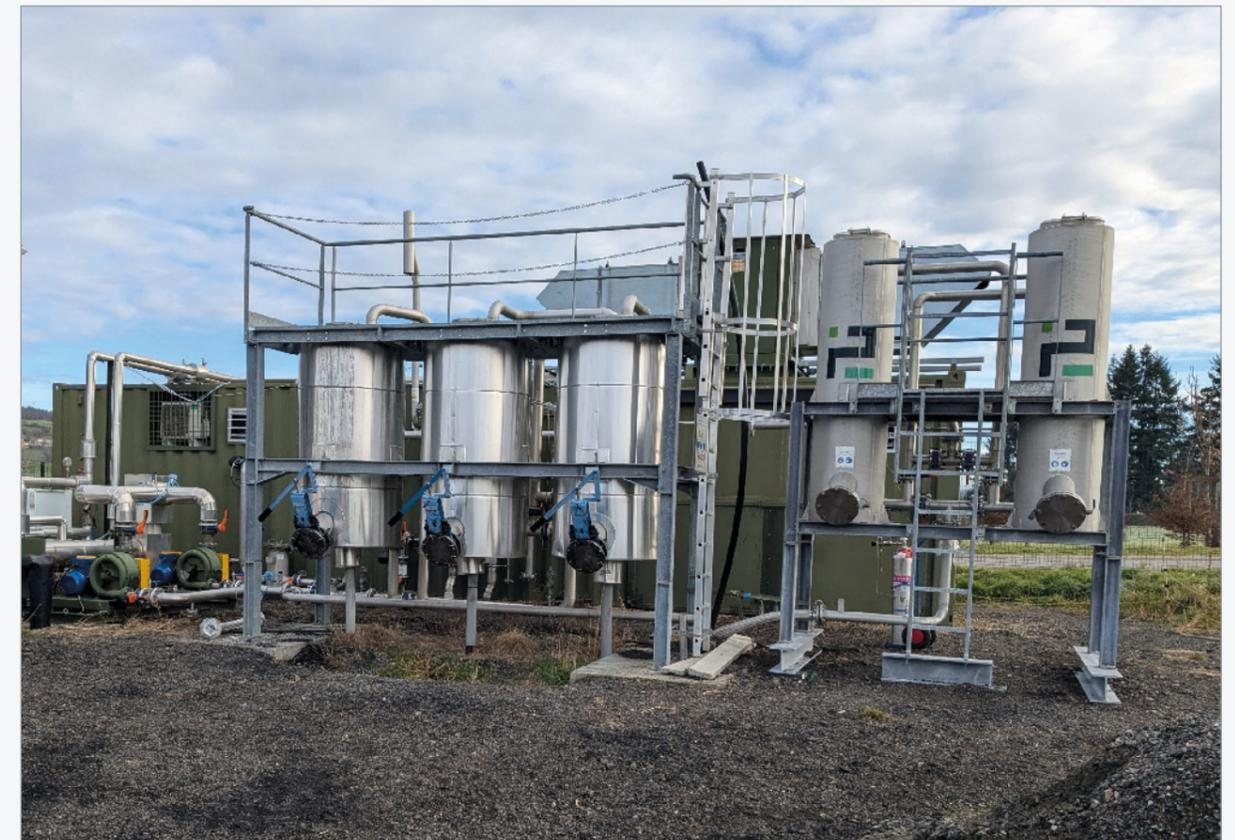
Expérimentation de désulfuration et désoxygénation par des sels ferriques sur le site biométhane de Méthamoly.
