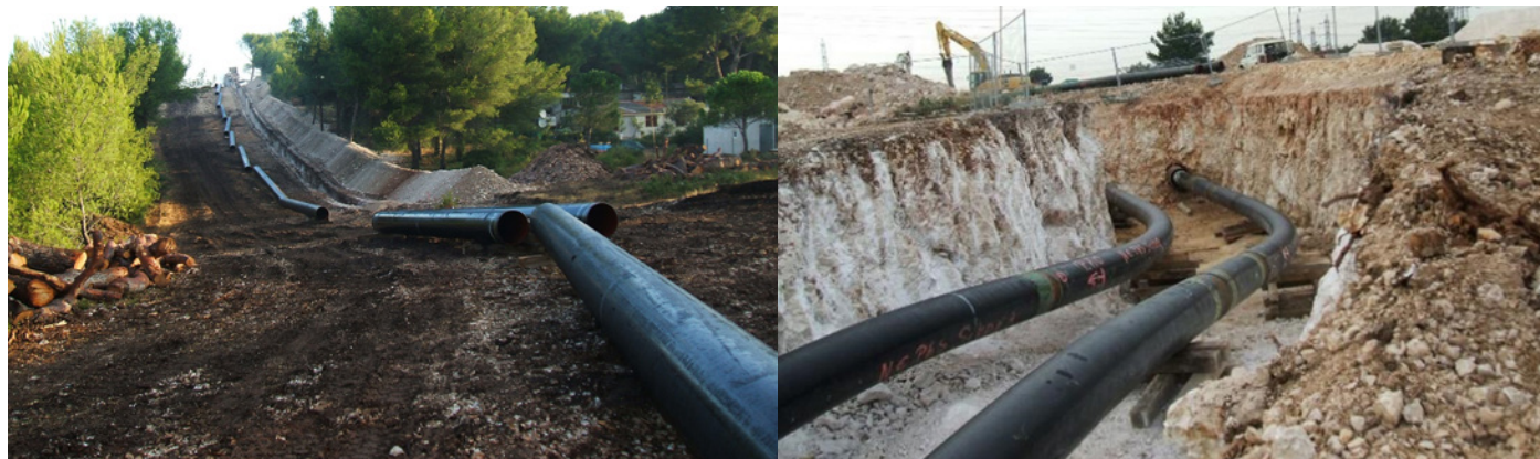
Exemples de canalisations NaTran, avant enfouissement
